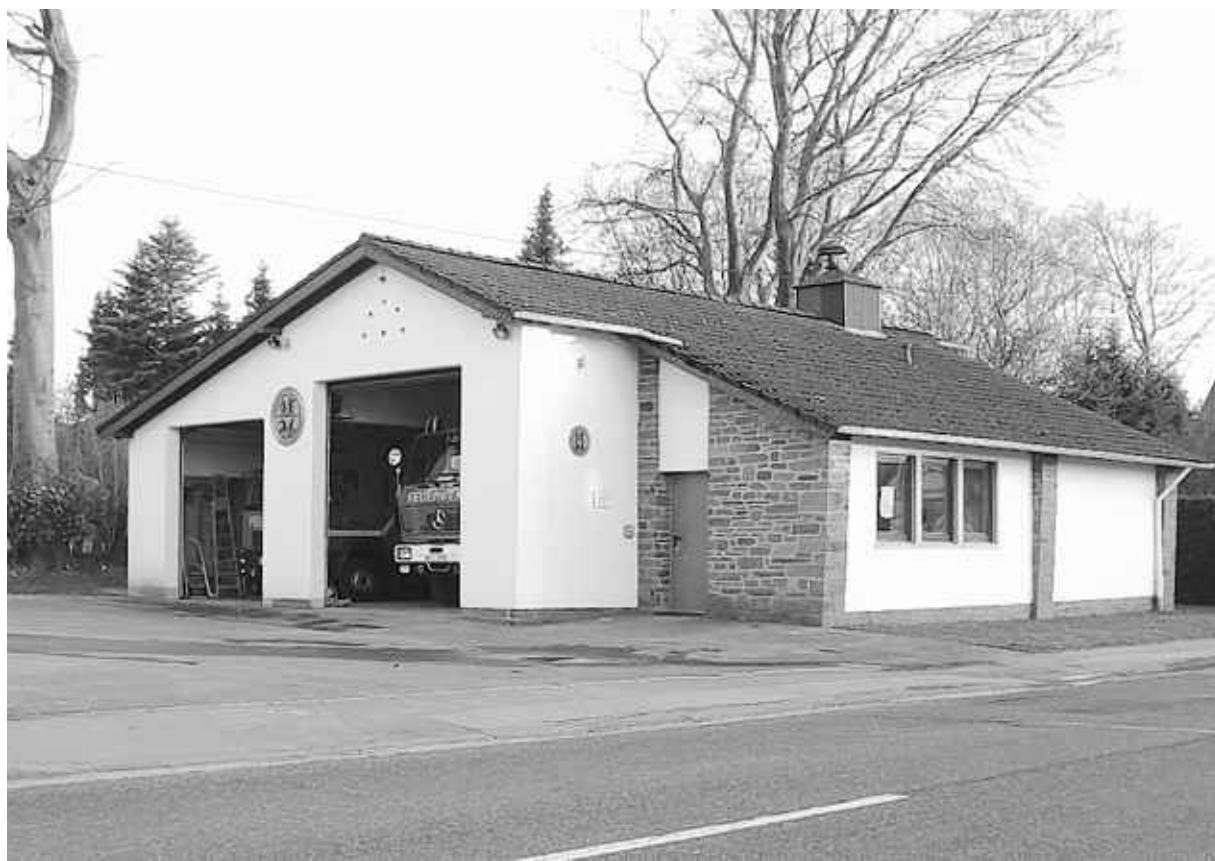
Das 50 Jahre alte Feuerwehr-Gerätehaus in Strauch wurde nun um einen Mannschaftsraum erweitert. Die Löschgruppe Strauch stellte das Feuerwehrgerätehaus gestern im Rahmen eines Tages der offenen Tür der Bevölkerung vor.
