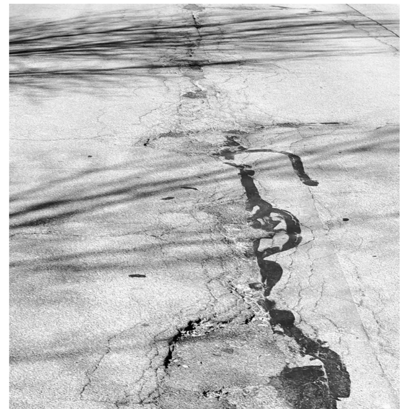
Unbestritten muss die Lindenstraße in Simmerath im Bereich der Dreifachturnhalle ausgebessert werden, doch Kosten von fast 50 000 Euro für eine dauerhafte Instandsetzung waren dem Tiefbauausschuss zu teuer. Foto: Münker
